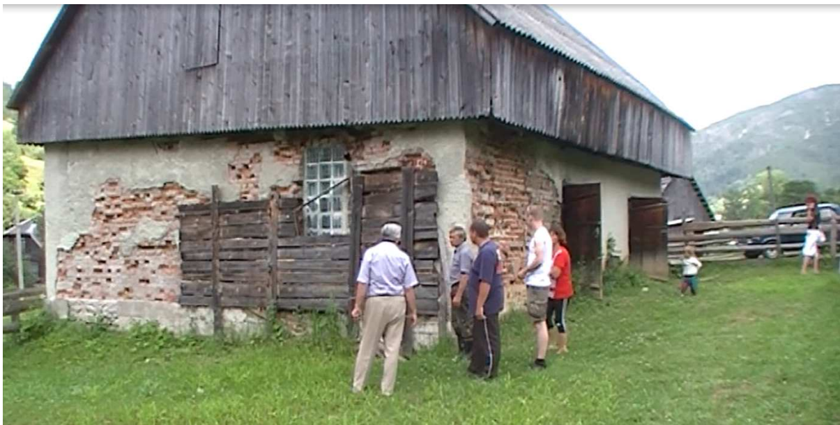
Het nieuwe huis, genoeg ruimte maar nog niet woonbaar
